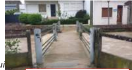
Environ 1 à 2 cm d'eau sur la passerelle (Ztablier = 53,87 mNGF) au moment du pic de crue
